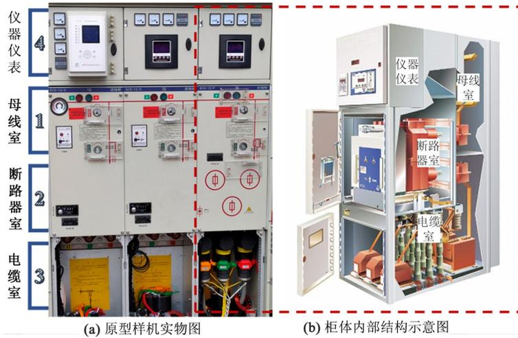
图 1 10 kV 高压开关柜原型样机及其内部结构示意图
